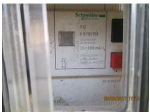
Non-conformité entre le réglage du disjoncteur et la puissance souscrite du compteur.
