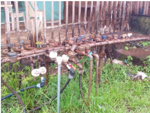
Image 2 : Regroupement monstrueux de compteurs eau
