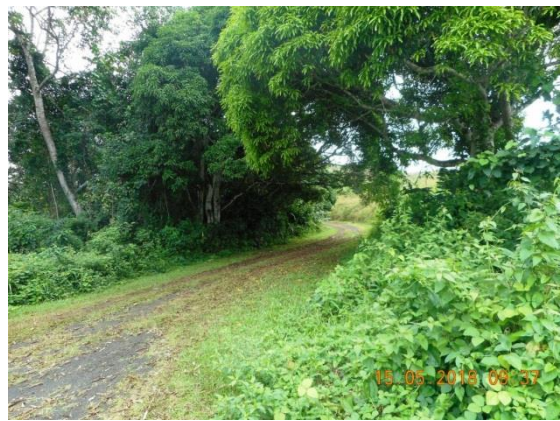
Image 2 : Accès de la prise eau brute non sécurisé
