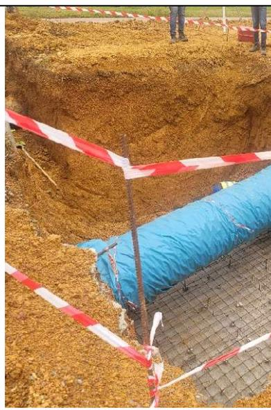
Photo 3 : Canalisation d'alimentation DN800 du château d'eau
