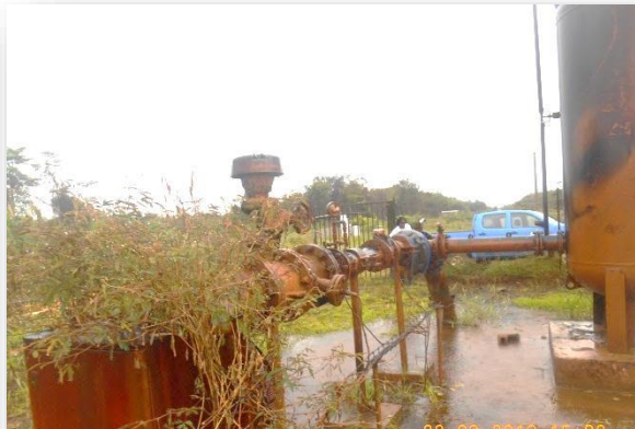
Photo 2 : Autre vue du site du forage F3.
