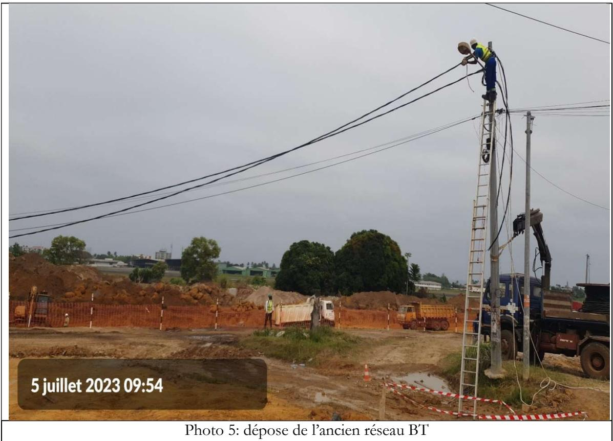
Photo 5: dépose de l'ancien réseau BT
