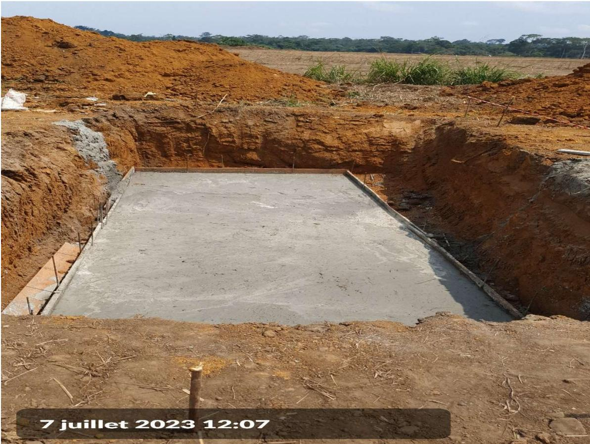
Photo 2 : fondations pour la structure des panneaux solaires
