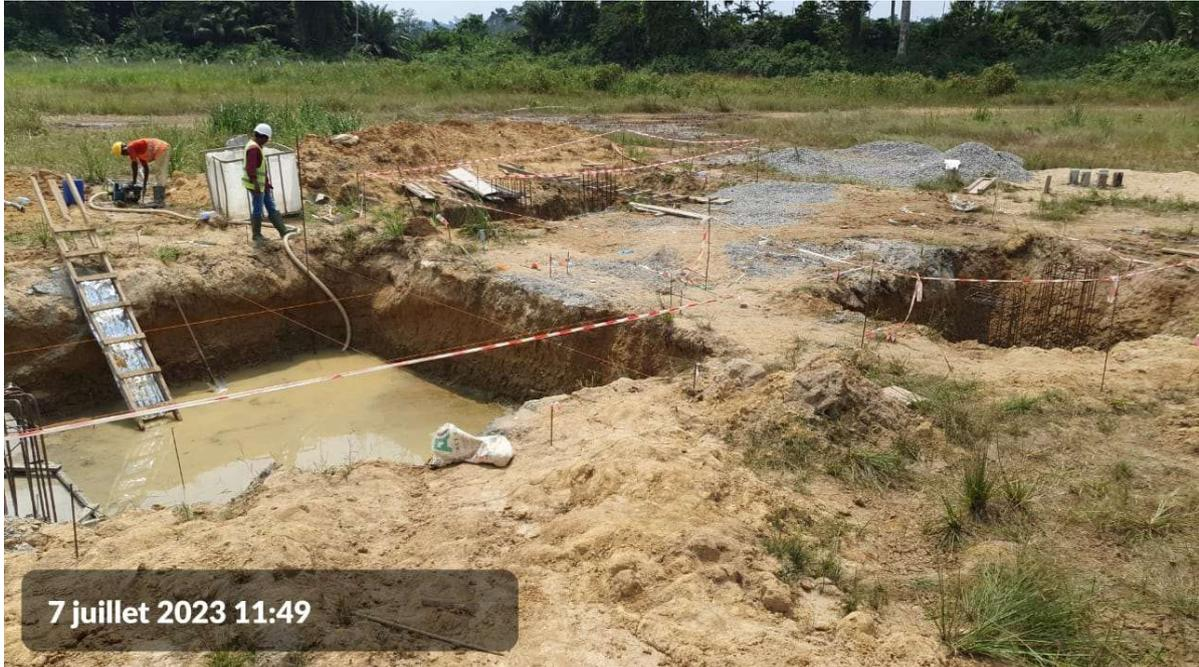
Photo 4 : travaux de fondations du poste d'évacuation d'énergie
