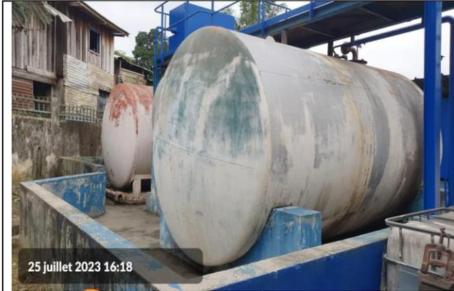
Photo 34 : cuves de stockage de combustible
