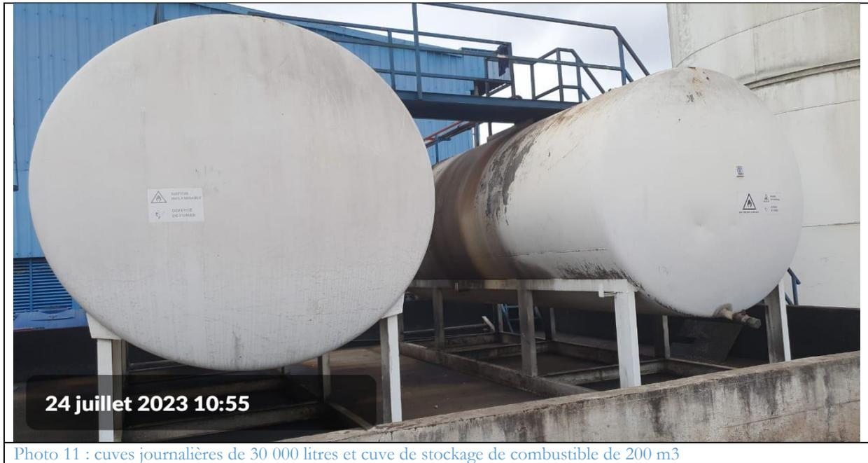
Photo 11 : cuves journalières de 30 000 litres et cuve de stockage de combustible de 200 m3
