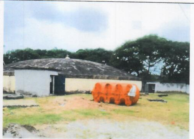
Réservoir de 1500m 3 hors service au PK6
