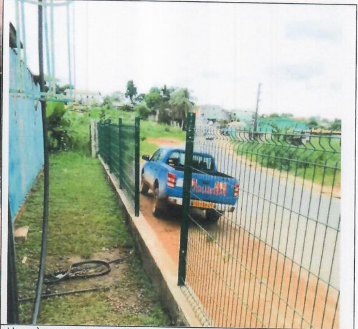
L'accès au surpresseur d'Awoungou n'est pas sécurisé.
