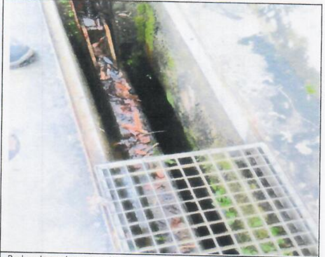
Batardeau hors service
