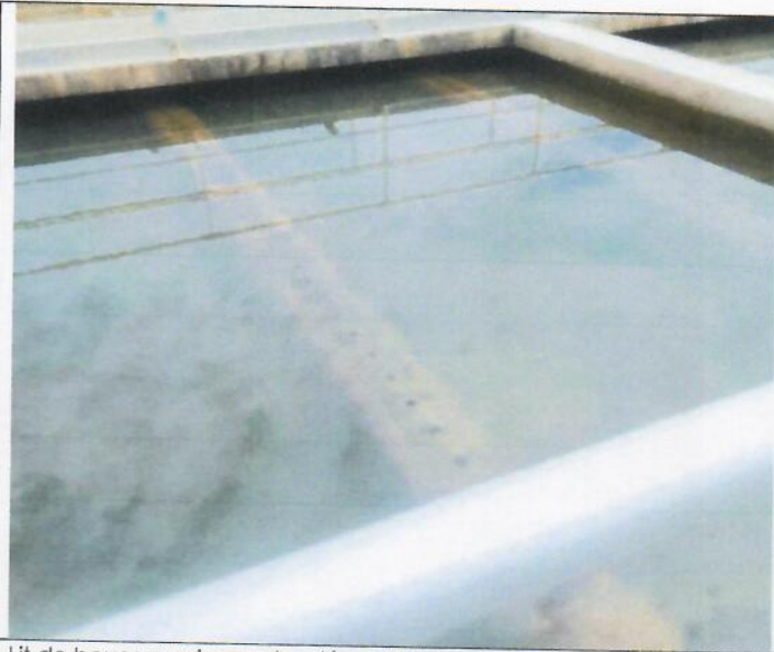
Lit de boues au niveau des décanteurs
