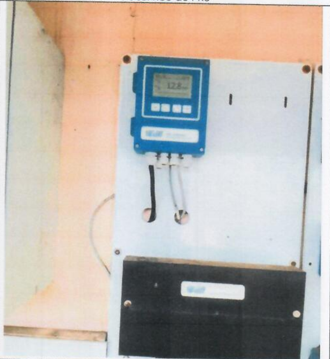
Analyseur en ligne PK9 hors service
