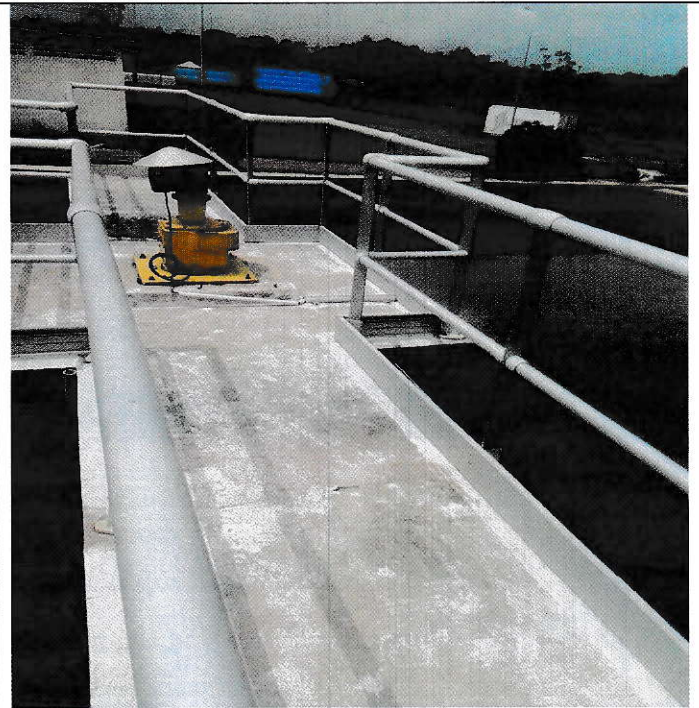
Agitateur décanteur Ntoun 6 hors service
