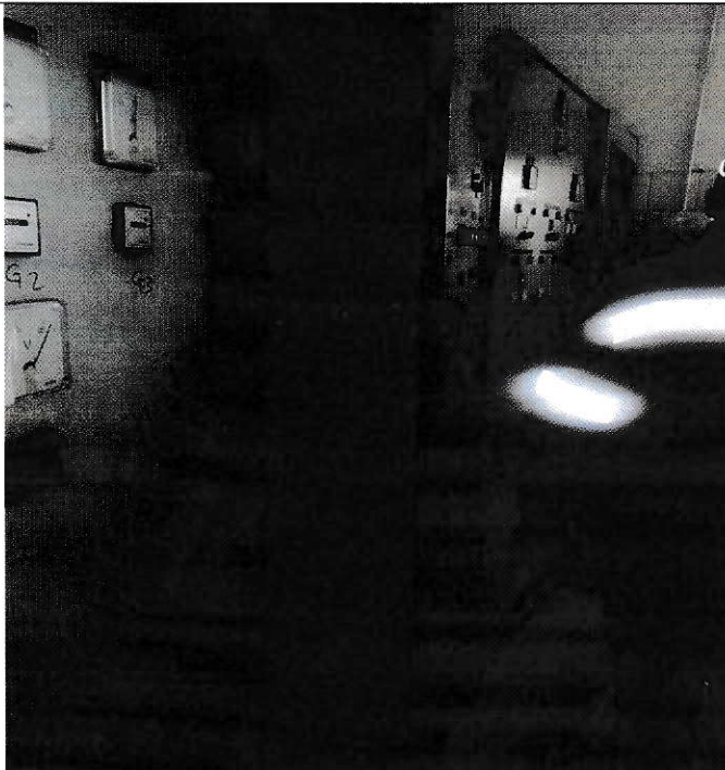
Armoires électriques obsolètes
