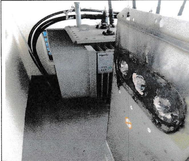
Poste d'alimentation de la station d'eau potable de 250 KVA hors service
