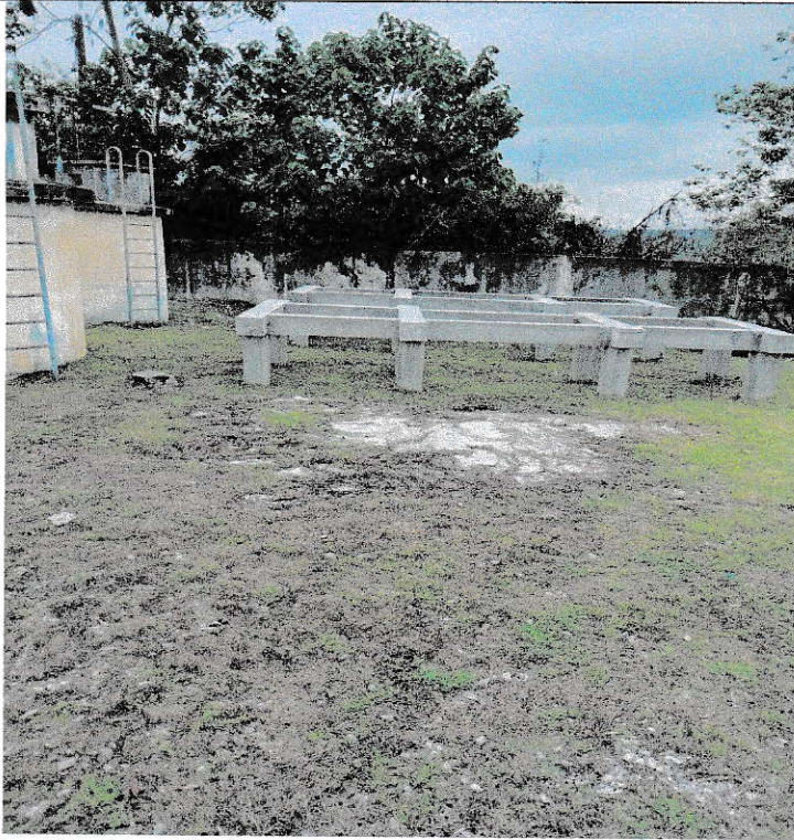
Travaux de la nouvelle bêche
