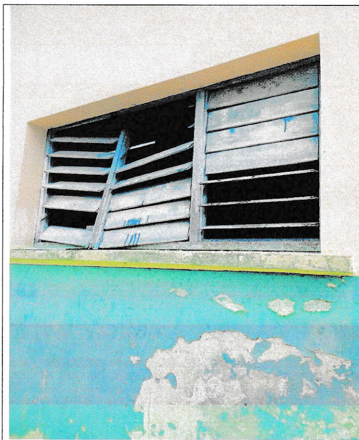
Bâtiment de l'ancienne station
