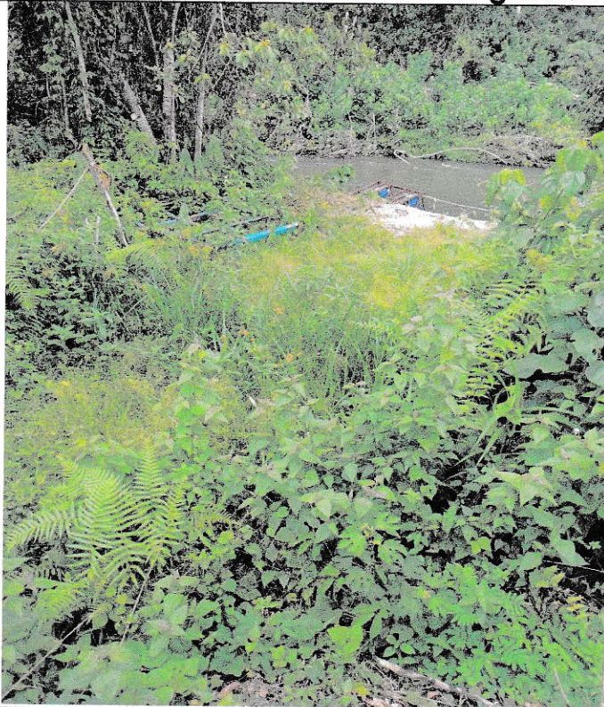
Difficultés d'accès à la prise d'eau
