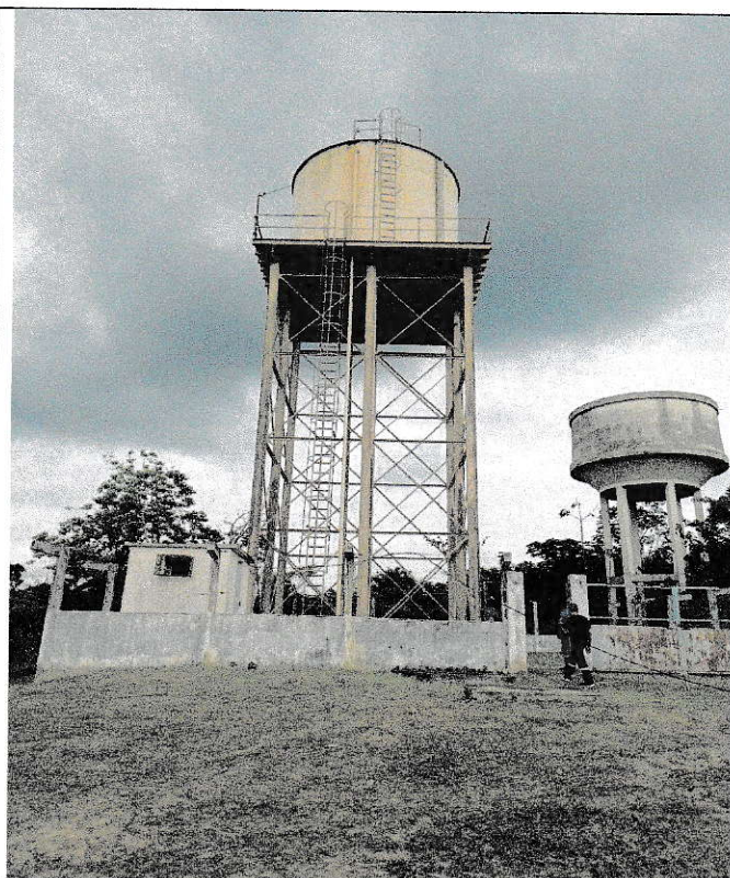
Château d'eau en béton non fonctionnel à côté du château d'eau métallique
