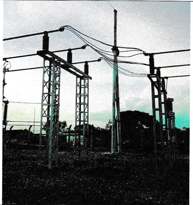
Absence de disjoncteurs de couplage entre les jeux de barres
