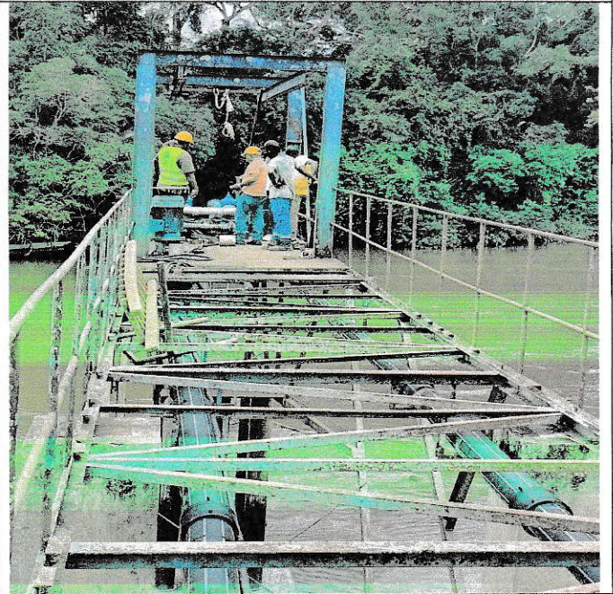
Difficultés d'accès à la prise d'eau
