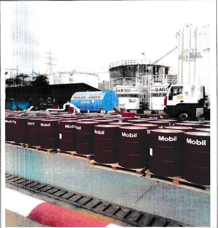
Stockage de gasoil et d'huiles
