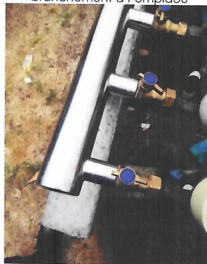
Nourrice en inox sur un branchement alimenté à Plaine-Oréty
