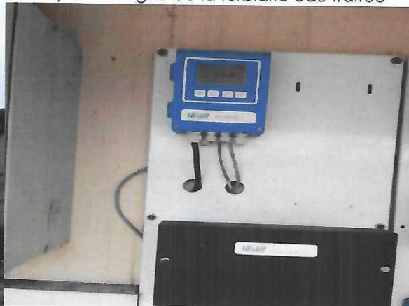
Analyseur en ligne PK9 hors service
