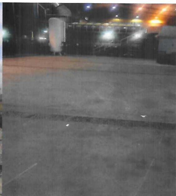
Centrale thermique du Cap Lopez : Emplacement réservé pour l'augmentation des moyens de production
