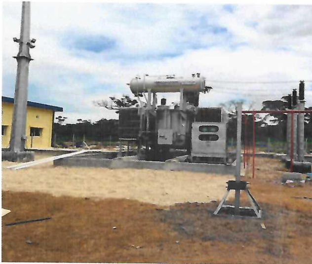
Centrale solaire d'Ayeme plaine : Transformateur 33/90 KV
