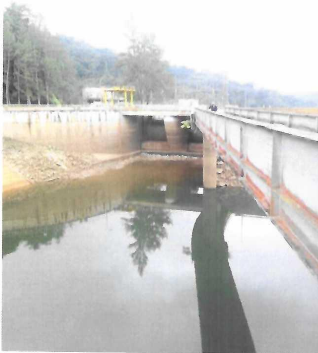
Centrale de Tchimbélé : Niveau de la retenue à 1.93m de la côte d'alerte
