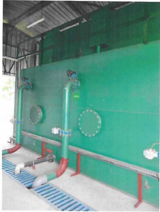
Nouvelle Station de traitement d'eau Akieni
