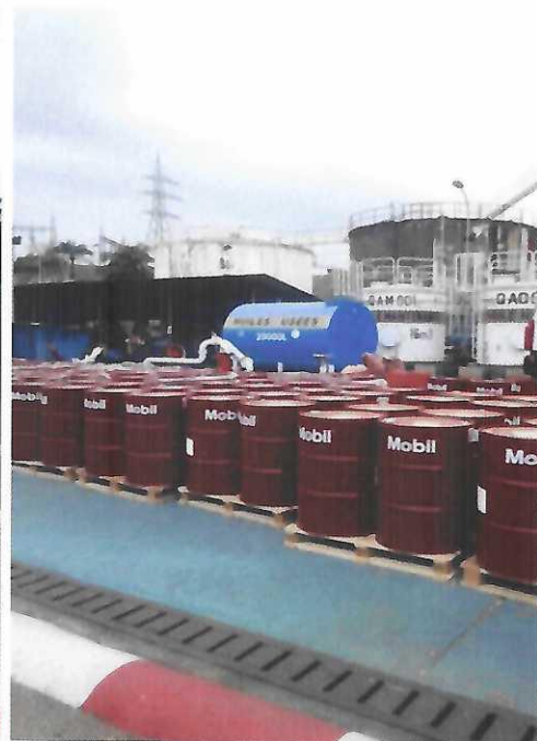
Centrale d'Akournam : Stockage de gasoil et d'huiles
