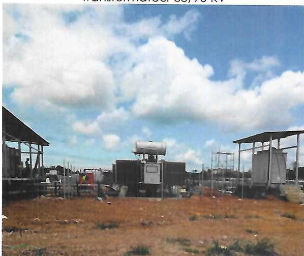
Centrale solaire d'Ayeme plaine : Transformateur 33/90 KV
