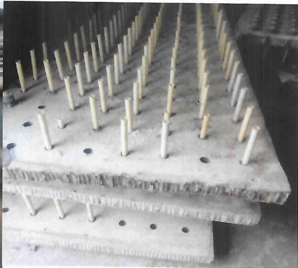
Station de traitement NTM3/4 : Plancher de filtres fissurés
