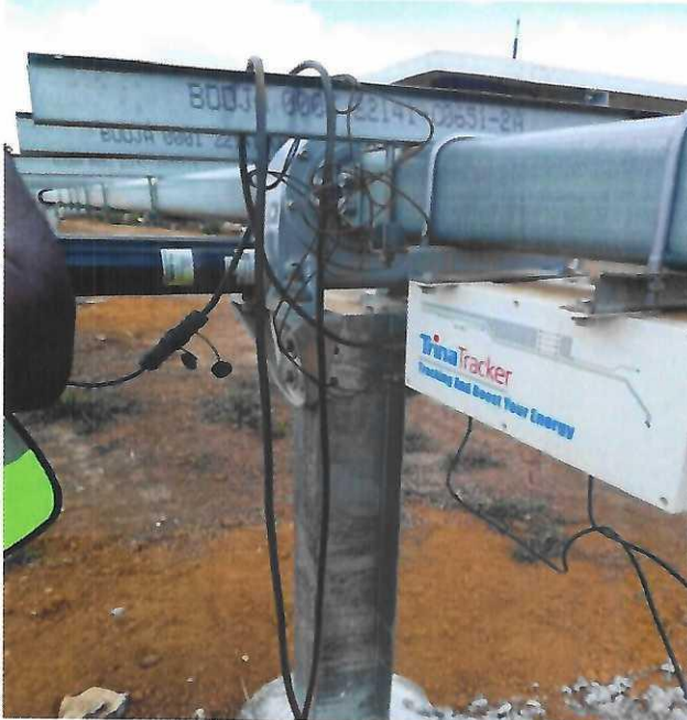
Centrale solaire d'Ayeme plaine : Système de tracker
