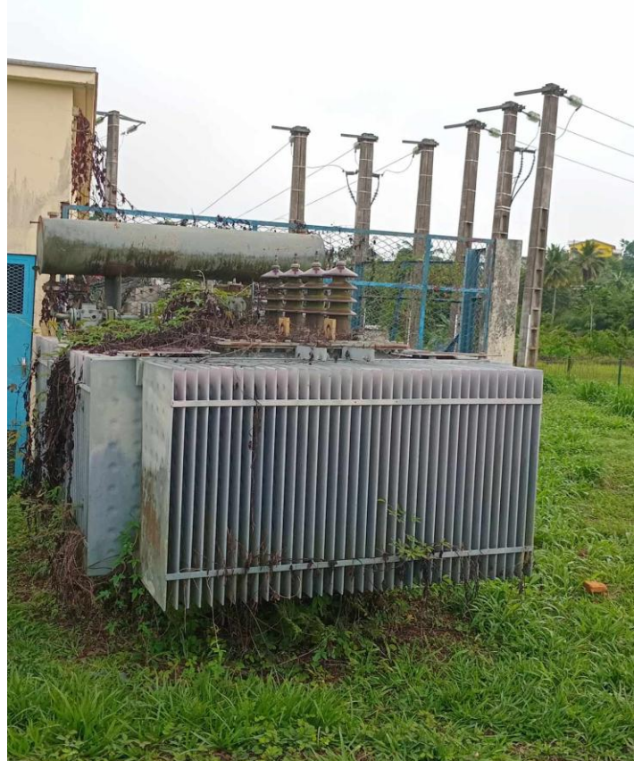
Transformateur n°1, 30/5.5 KV déposé depuis plusieurs années
