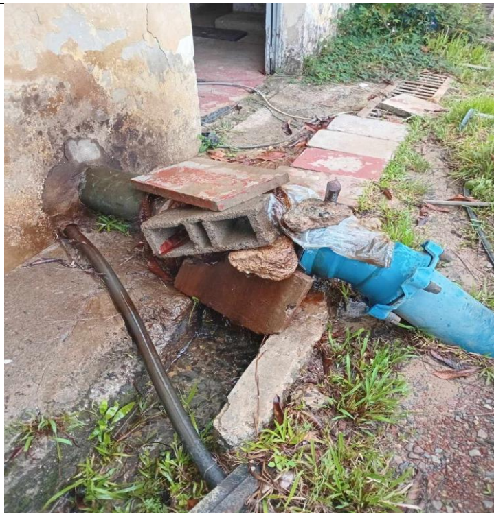
Fuite conduite de refoulement
