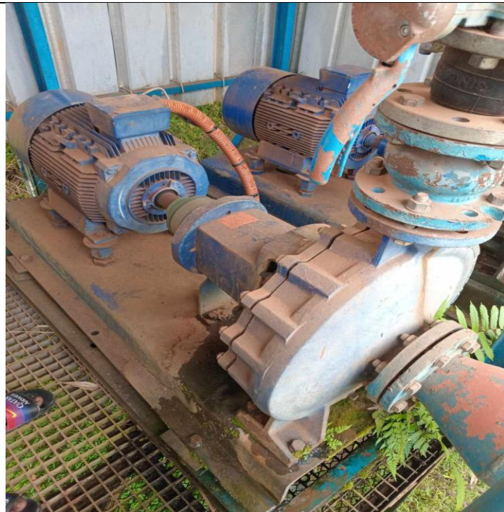
Baisse des performances des pompes eau brute
