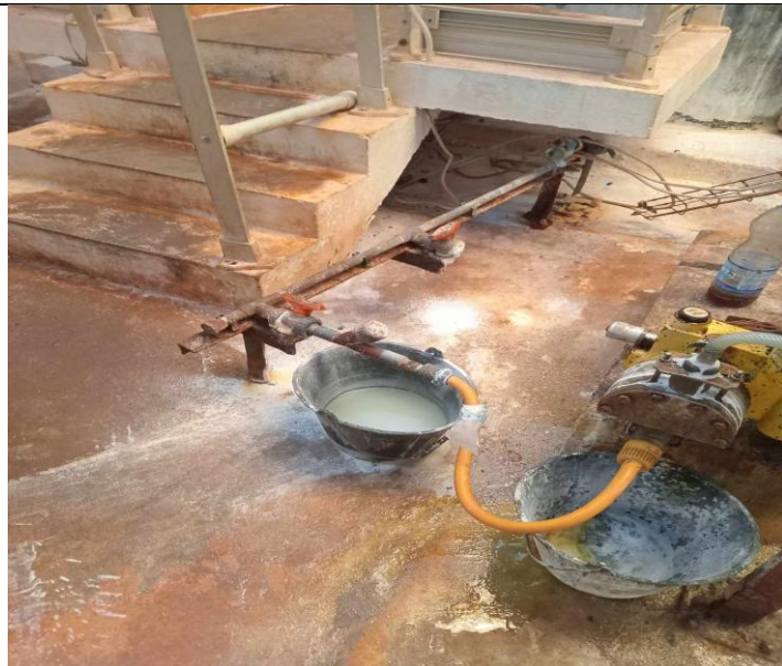
Fuite d'eau au niveau de la pompe doseuse des réactifs et absence de pompes doseuses de secours
