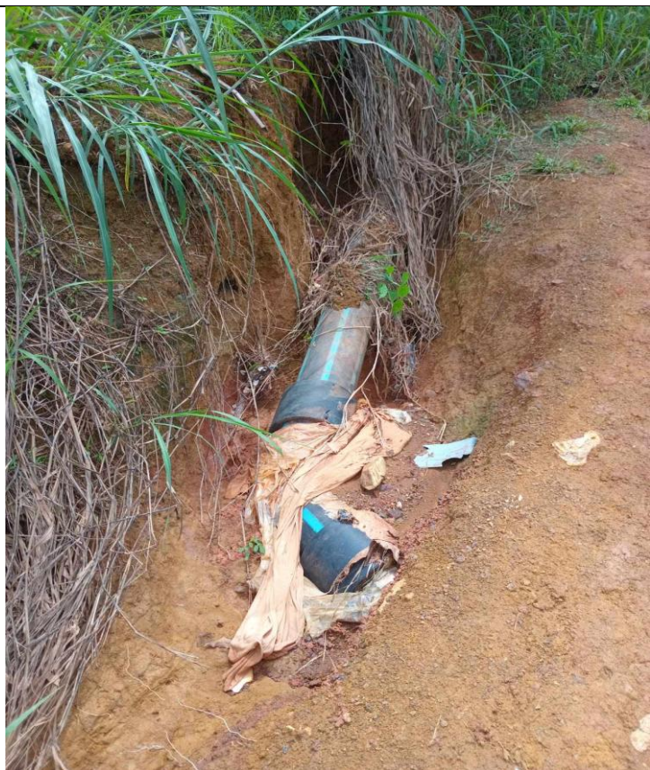
Conduite eau brute visible suite au ravinement des sols
