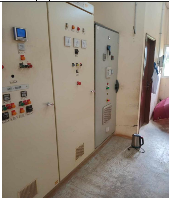
Armoires électriques obsolètes
