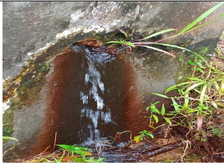
Fuite d'eau au niveau de la bâche eau traitée
