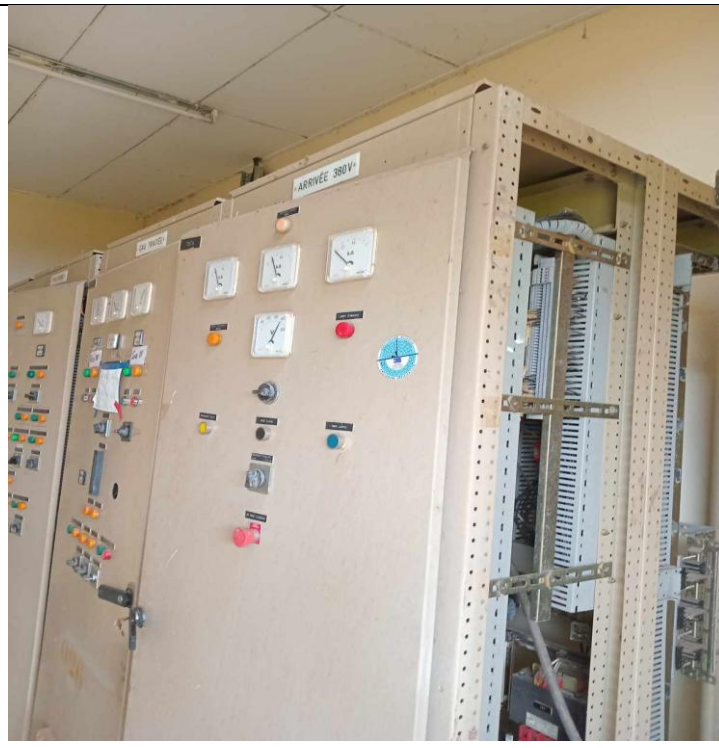
Armoires électriques vétustes et obsolètes
